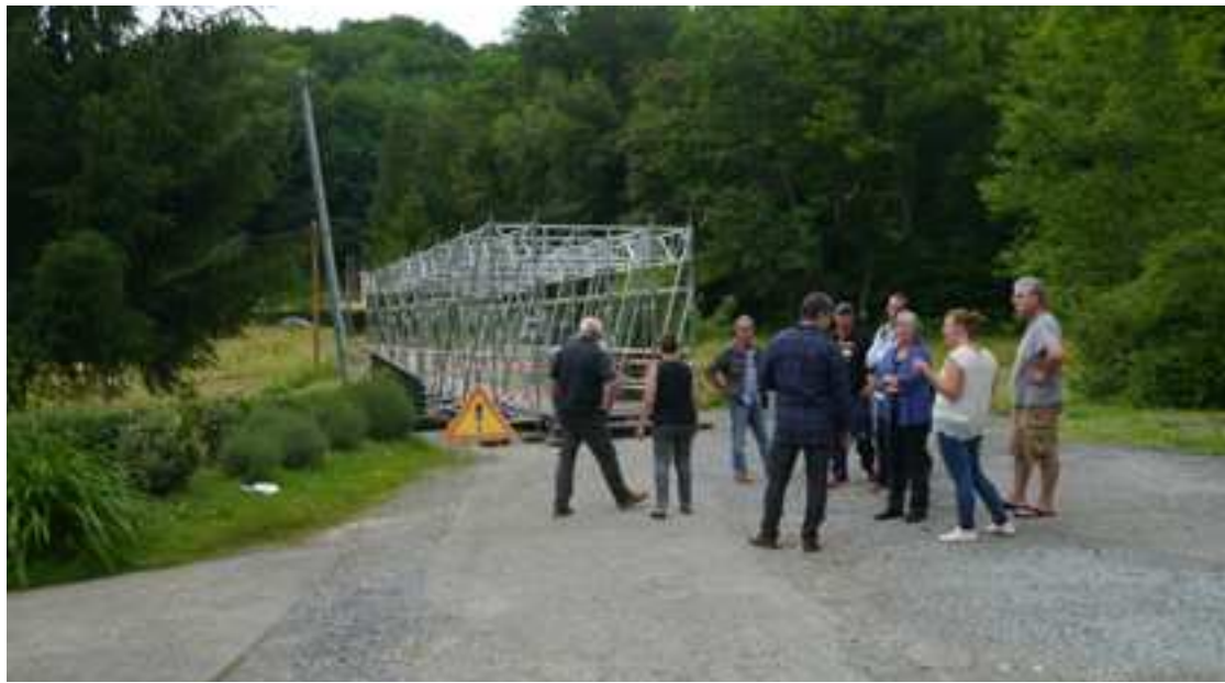
Riverains et élus devant le pont piéton tout juste installé. © STÉPHANE DE NODREST
