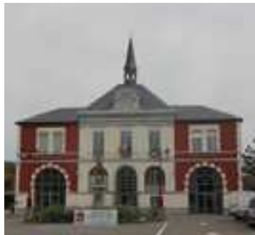
La mairie de Pontacq fera l'objet de travaux d'accessibilité. © LOUISICHOUREBÈRE
